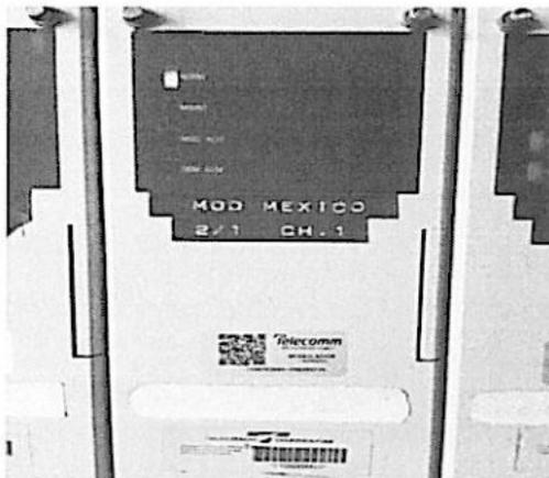
En la parte MOD y DEM no tiene que existir ninguna alarma, como se observa en la imagen.
